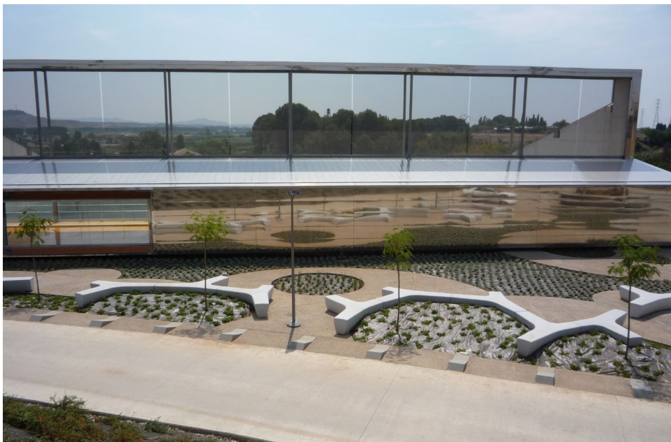
Figura 4 Foto del Tanque de tormentas de Tudela
